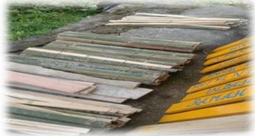
Gambar. 5 diatas merupakan potongan bambu yang sudah dibersihkan dan proses pengeringan potongan bambu sebelum disatukan pada kerangka yang sudah dibuat sebelumnya.
